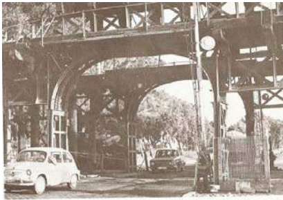
Figura 28. Paso de circulación rodada bajo el muelle de Riotinto (Archivo de los autores).
