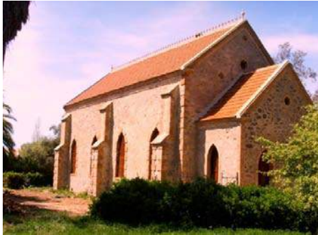
Figura 15. La capilla evangélica de Riotinto restaurada (Fotografía de los autores)
