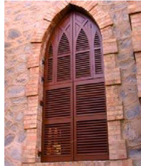
Figura 16. Detalle de ventana de la capilla de Riotinto. (Fotografía de los autores)
